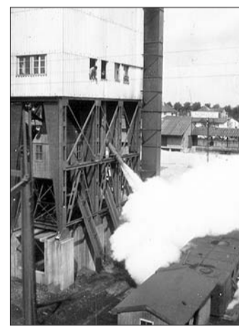
Dampfausstoß aus den Perkolatoren. Wenn nach etwa zwölf Stunden die Holzverzuckerung im Perkolator beendet war, wurde der schwefelhaltige Dampf aus dem Reaktionsraum abgelassen, der zu Reizungen des Rachens und der Augen führte. Ab 1932 verbreitete sich in Tornesch der typisch süßliche Geruch dieser Produktion. Foto Archiv Kulturgemeinschaft.
