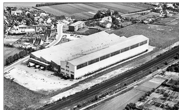
Luftaufnahme der Altonaer Wellpappenfabrik von 1965. Foto Archiv Kulturgemeinschaft.
