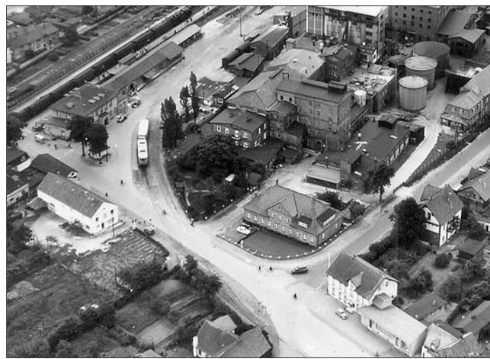
Das Verwaltungsgebäude bzw. alte Wohnhaus der Brennerei, in der Bildmitte an der Kreuzung auf einer Luftaufnahme von 1956, wurde 1982 abgebrochen für den Bau des Einkaufszentrums Tornescher Hof. Foto Archiv Kulturgemeinschaft.
