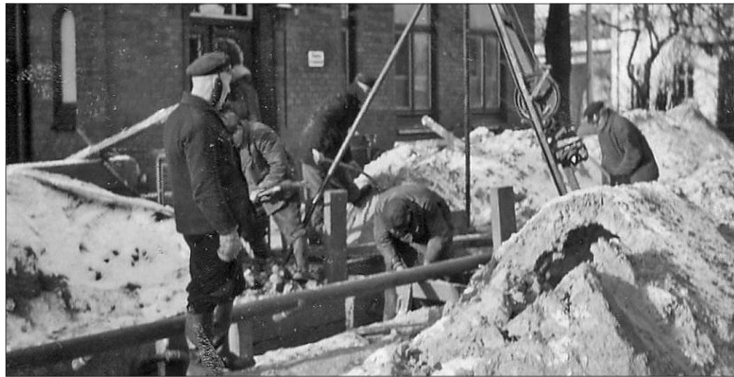
Verlegung der Kanalisation vor dem alten Posthaus 1955 in der Esinger Straße. Foto: Stadtarchiv Tornesch
